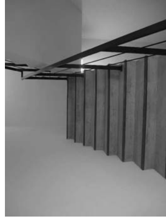
ภาพบันไดหนีไฟและเส้นทางหนีไฟ ไม่มีสิ่งกีดขวาง ผนังหรือประตูทำด้วยวัสดุทนไฟ สามารถใช้หนีภัยในกรณีฉุกเฉินได้
