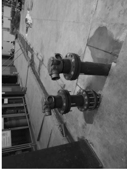
หัวรับน้ำดับเพลิงด้านหลังอาคาร
