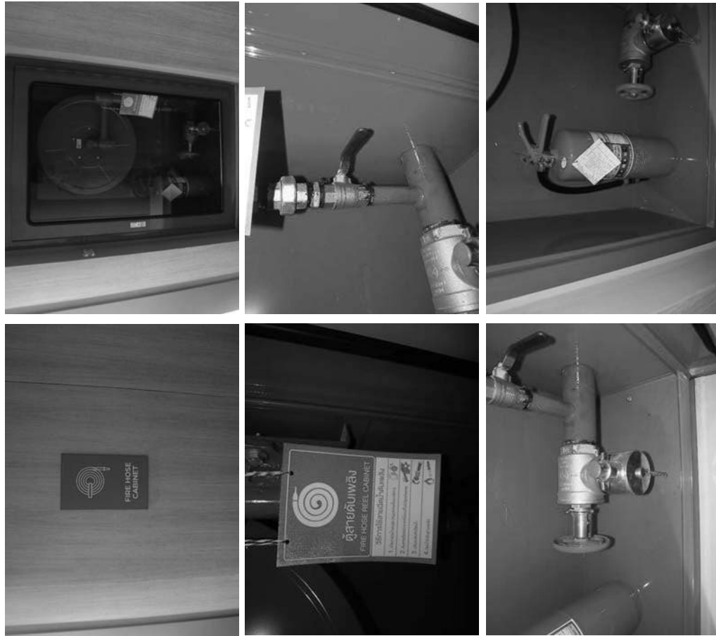
ภาพตู้ FHC สายฉีดน้ำดับเพลิง และถังดับเพลิง มีการตรวจสอบเบื้องต้นจากทางฝ่ายอาคาร
