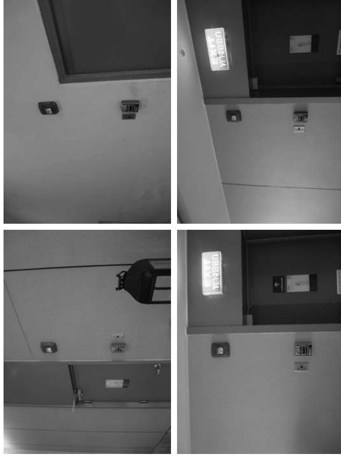
ภาพระบบสัญญาณแจ้งเหตุเพลิงไหม้ด้วยมือและกระดิ่งแจ้งเหตุ มีการตรวจสอบเบื้องต้นจากทางฝ่ายอาคาร
