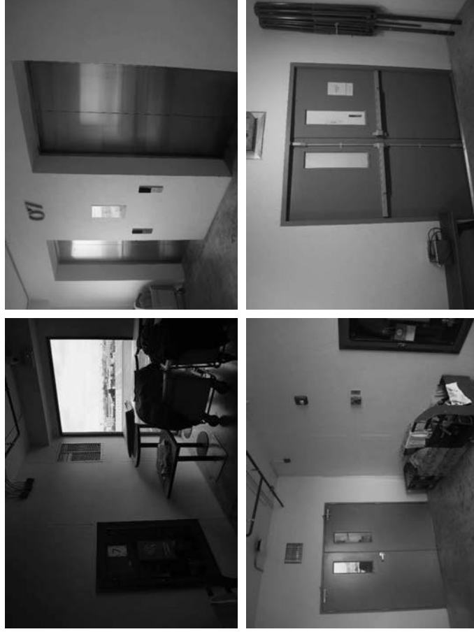
ภาพลิฟต์ดับเพลิง มีพื้นที่ไม่น้อยกว่า 6 ตารางเมตร สามารถจอดได้ทุกชั้น เป็นพื้นที่ปลอดควันและเปลวไฟ และเป็นที่ตั้งของตู้ชาร์จดับเพลิงประจำชั้นของอาคาร
